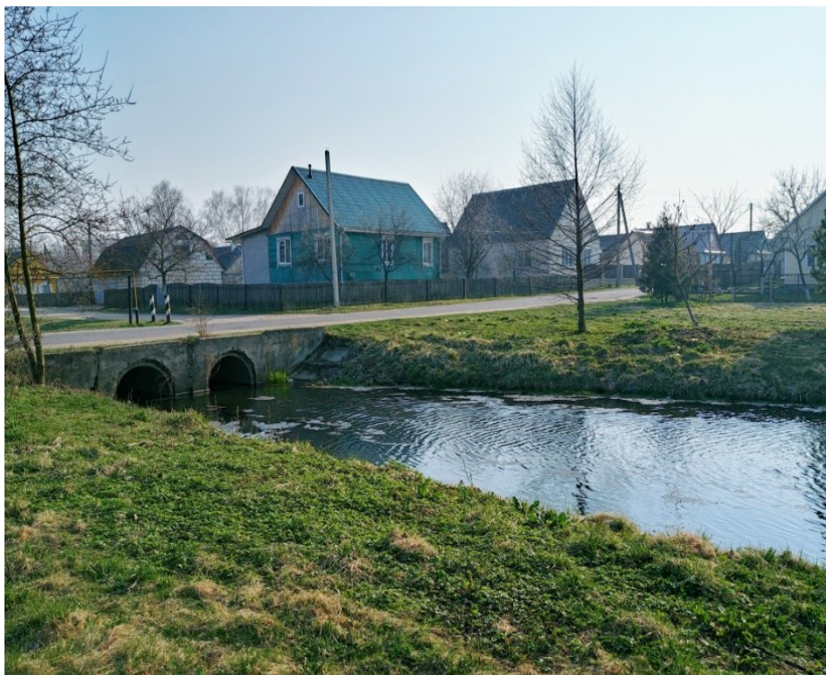
Рис.4 Река Бычок на пересечении ул. Первого Августа
